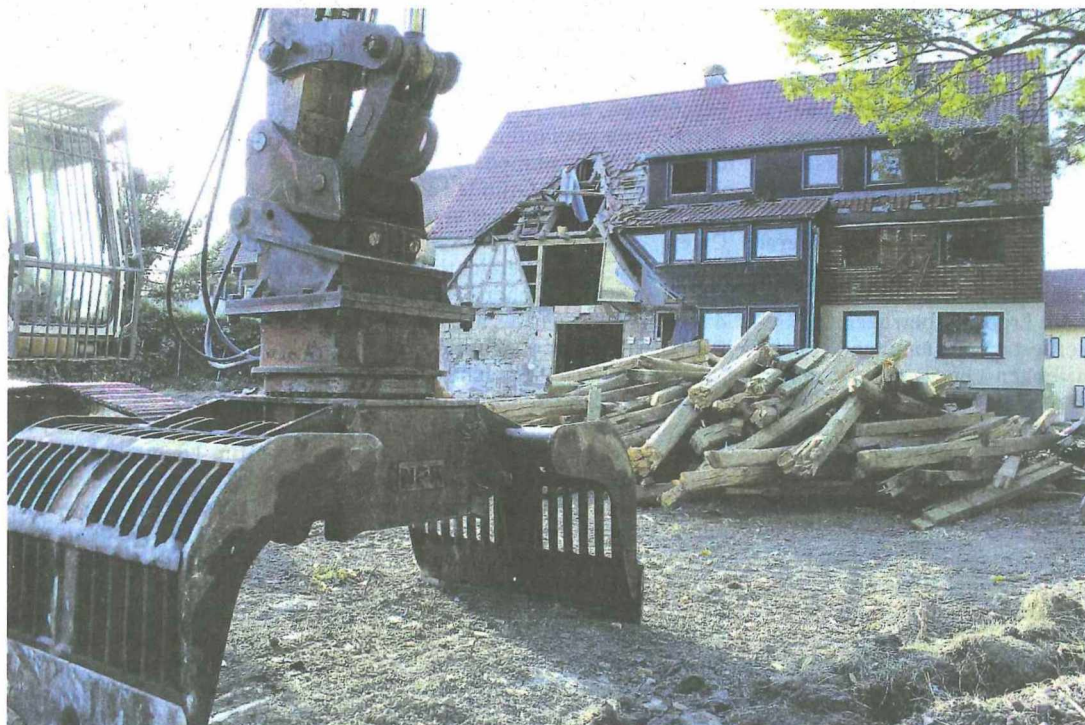
Damit der neue Dorfplatz an der Vorderen Straße in Dauchingen entstehen kann, wird derzeit das Pia-Laufer-Haus Stück für Stück abgerissen. Foto: Eric Zerm
