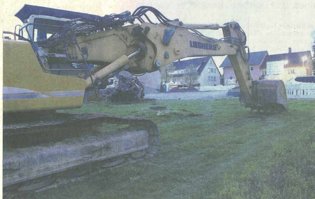
Die Arbeiten für den Bau des Dorfplatzes Dauchingen haben Anfang der Woche begonnen.
