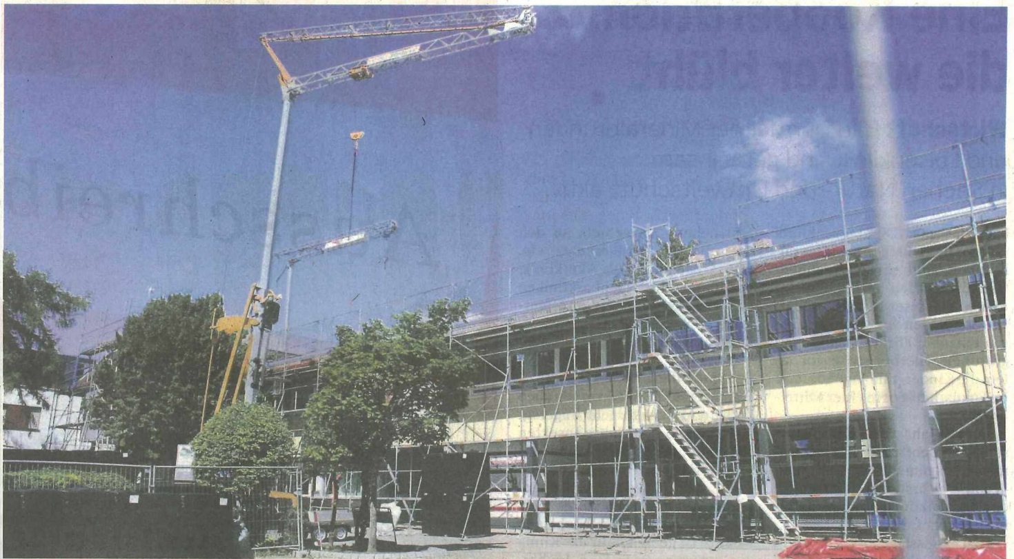
Voll eingerüstet zeigt sich derzeit das Dauchinger Schulgebäude, Grund dafür sind umfangreiche Dachsanierungsarbeiten.
