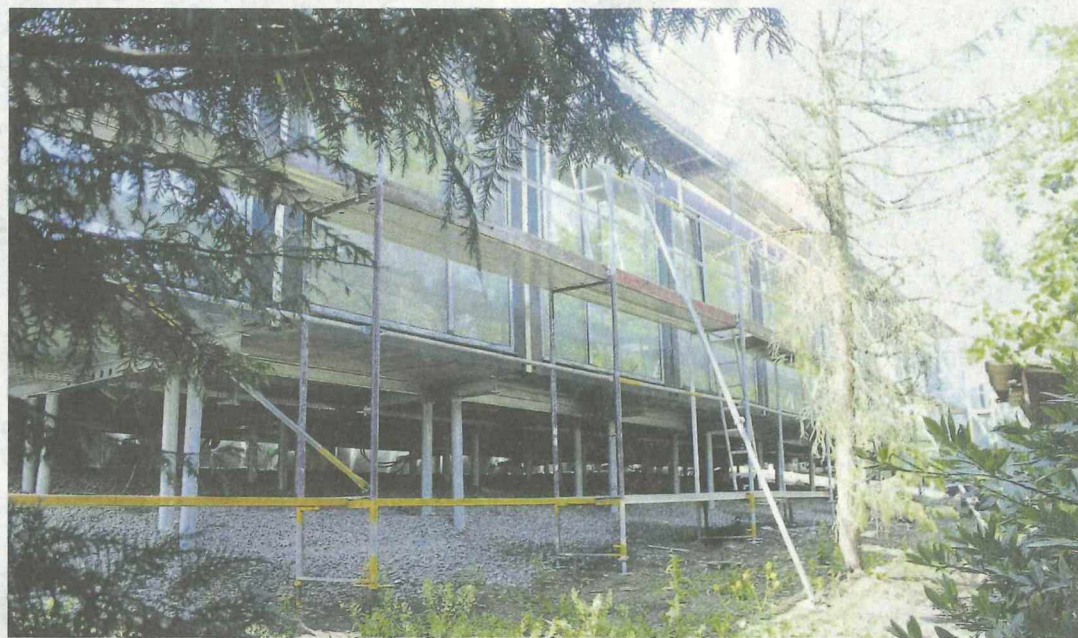
Auf diesem Foto kommt die besondere Konstruktionsidee der XS-Cube-Wohnkuben zur Geltung. Die Wohneinheiten stehen am Hang auf einer waagerechten Plattform, die wiederum auf Stelzen steht. Foto: Eric Zerm
