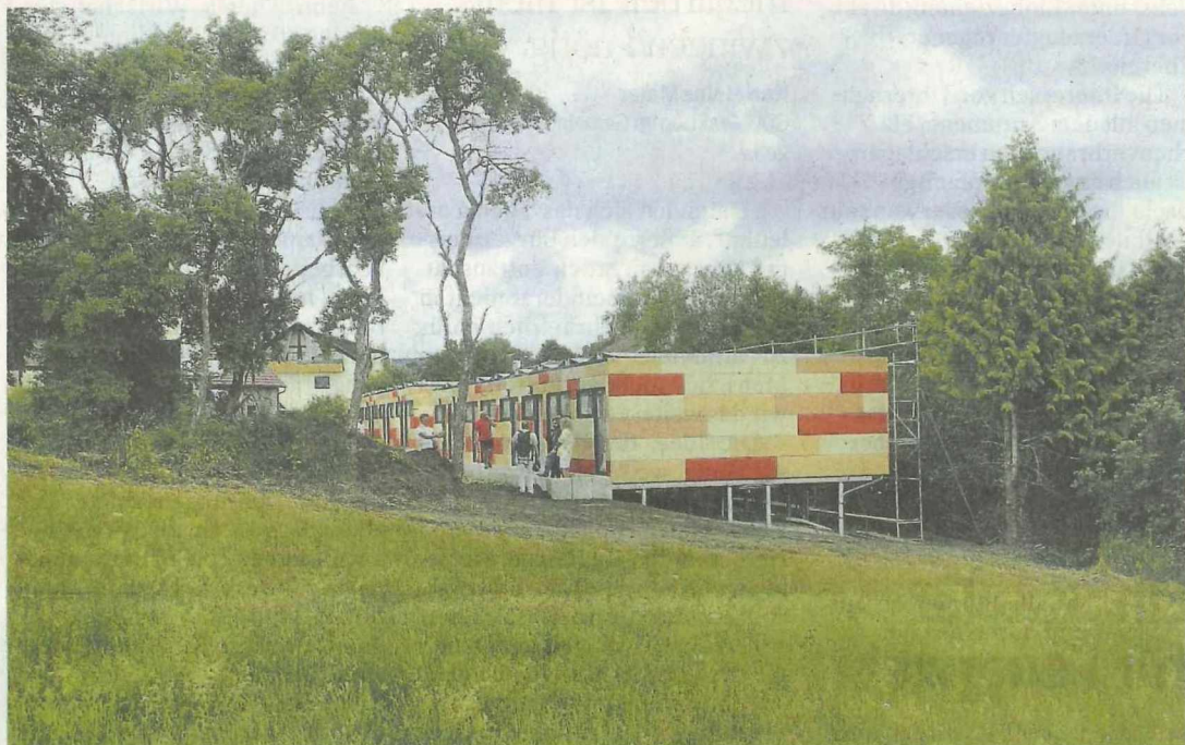
Foto oben: Ralf Ganter, der die Idee zu den Wohnkuben hatte, und Barbara Burkhardt-Ganter, Inhaberin des Unternehmens XS Cubes aus Nidereschach, freuen sich über den erfolgreichen Abschluss des ersten Großprojekts in Dauchingen. Foto unten: Die Wohnkuben an der Nidereschacher Straße sind inzwischen fertig und wurden vor wenigen Tagen der Gemeinde Dauchingen übergeben.
