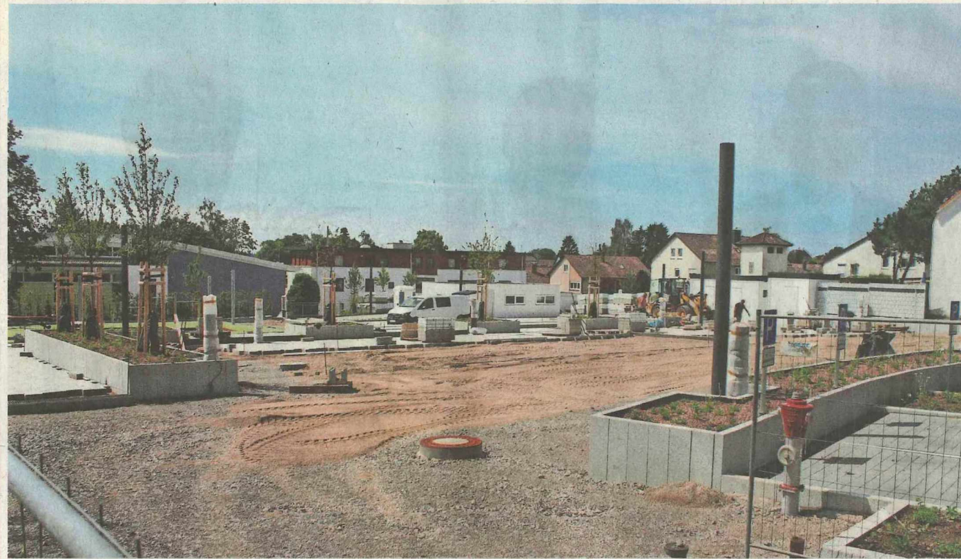
Arbeiten auf dem neuen Dorfplatz in Dauchingen. Am 14. und 15. September ist ein großes Einweihungsfest geplant.
