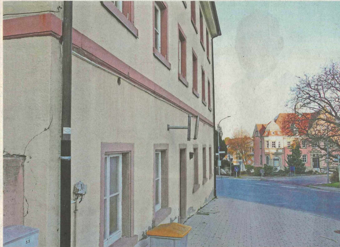
Der Gemeinderat gab den Startschuss zur Umnutzung des ehemaligen Pfarrhauses (links), das in zentraler Lage gelegen künftig zur Unterbringung von Vereinsräumen und Kindertagespflegereinrichtungen genutzt wird.
