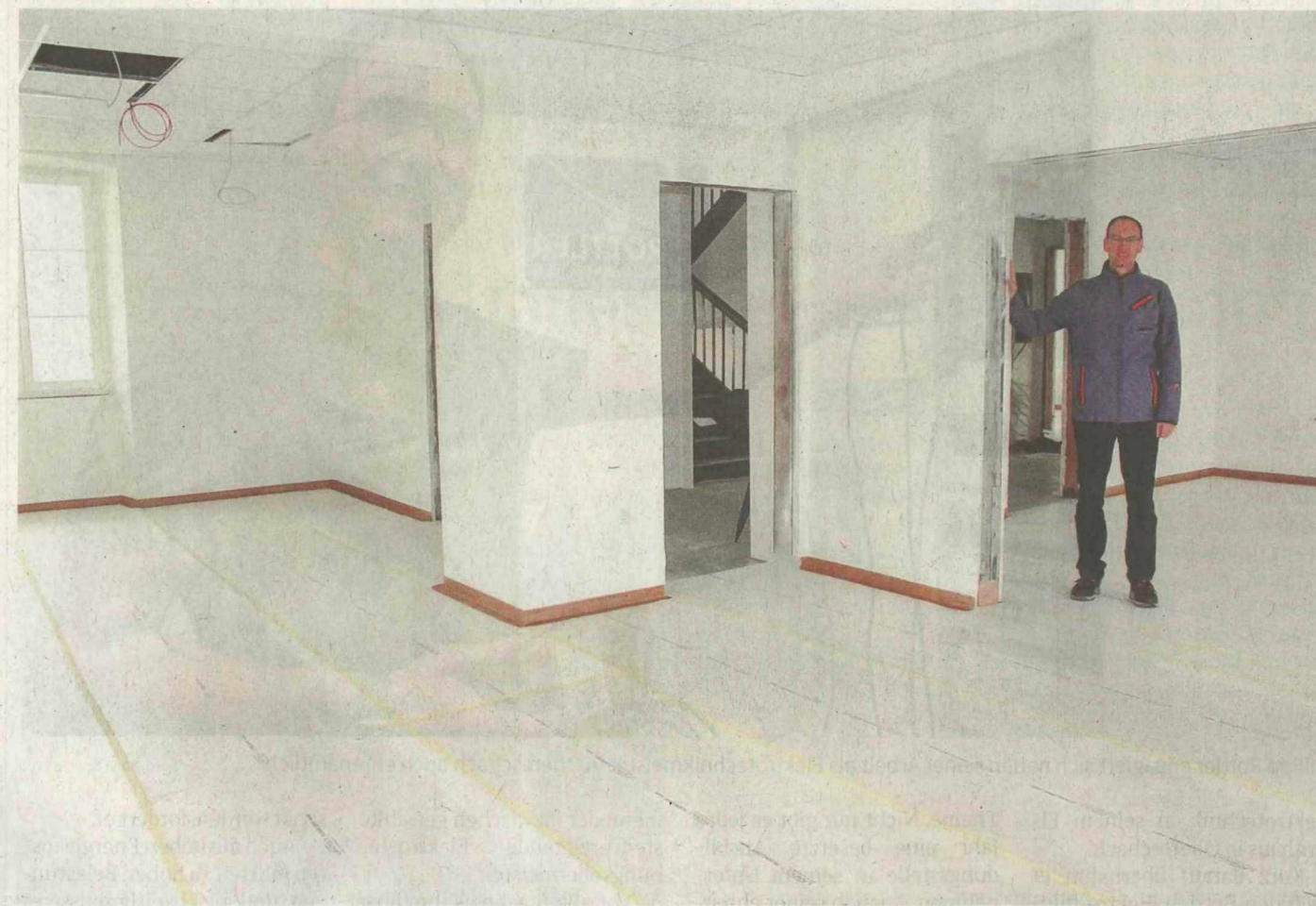
Bürgermeister Torben Dorn erkundigt sich über den Verlauf der Umbauarbeiten im Alten Pfarrhaus. Auf dem Bild zu sehen sind zwei der künftigen Vereinsräume mit der abgehängten Decke und dem schon verlegten Bodenbelag (ist von einem Schutzfließ abgedeckt), im Hintergrund das denkmalgeschützte Treppenhaus.
